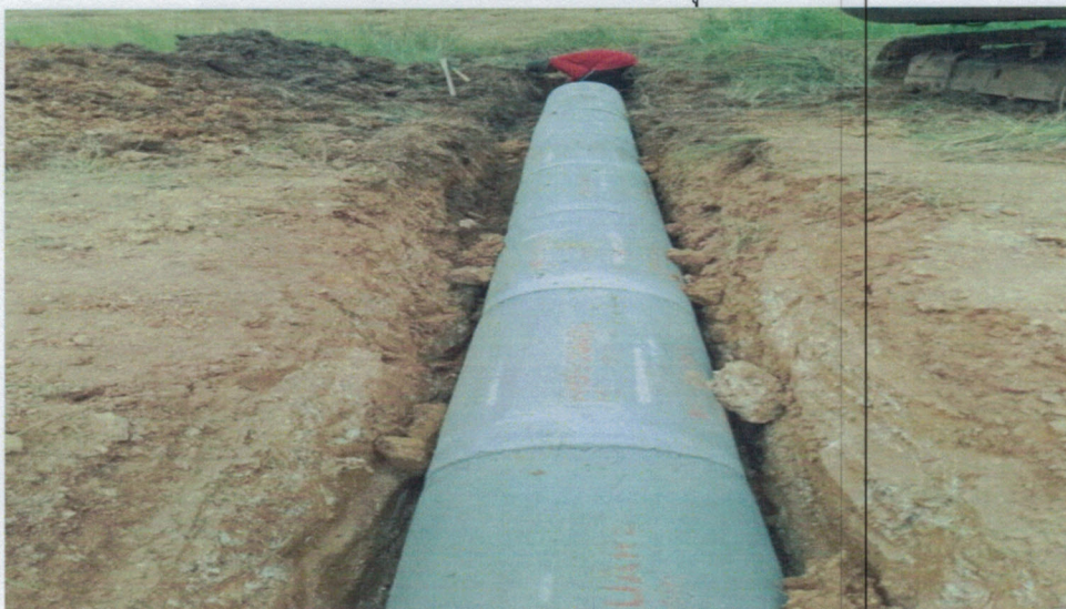
โครงการวางท่อระบายน้ำ คสล. (ลอดใต้ถนนเลียบคลองพระราชดำริ) หมู่ที่ 6 ตำบลพระยาทด อำเภอเสนาห์ จังหวัดสระบุรี
