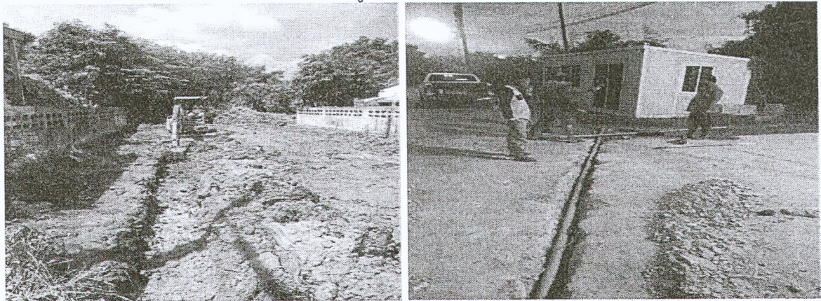
จ้างเหมารถแบ็คโฮขุดร่องระบายน้ำเสียหมู่บ้านเทียรชัยโครงการ ๒ และขยายเขตท่อเมนประปาหมู่บ้าน หมู่ที่ ๘ ต.ต้นตาล
