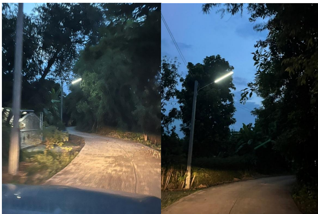
โครงการปักเสาไฟฟ้าส่องสว่างพร้อมพาดสายไฟและติดตั้งโคมไฟฟ้าสาธารณะ หมู่ที่ 6 ตำบลพระยาทต อำเภอสายไ้ จังหวัดสระบุรี (บริเวณถนนเลียบคลองวังงูเห่า-ถึงประปาหมู่บ้าน)
