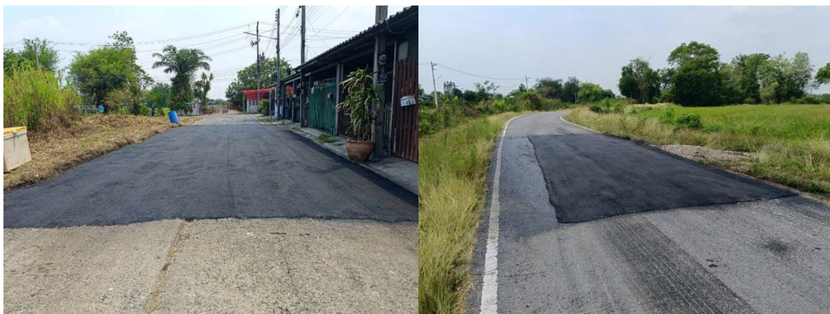
ซ่อมแซมถนนลาดยางแอสฟัลต์ติกคอนกรีต ตำบลต้นตาล และตำบลพระยาท อำเภอสายใต้ จังหวัดสระบุรี
