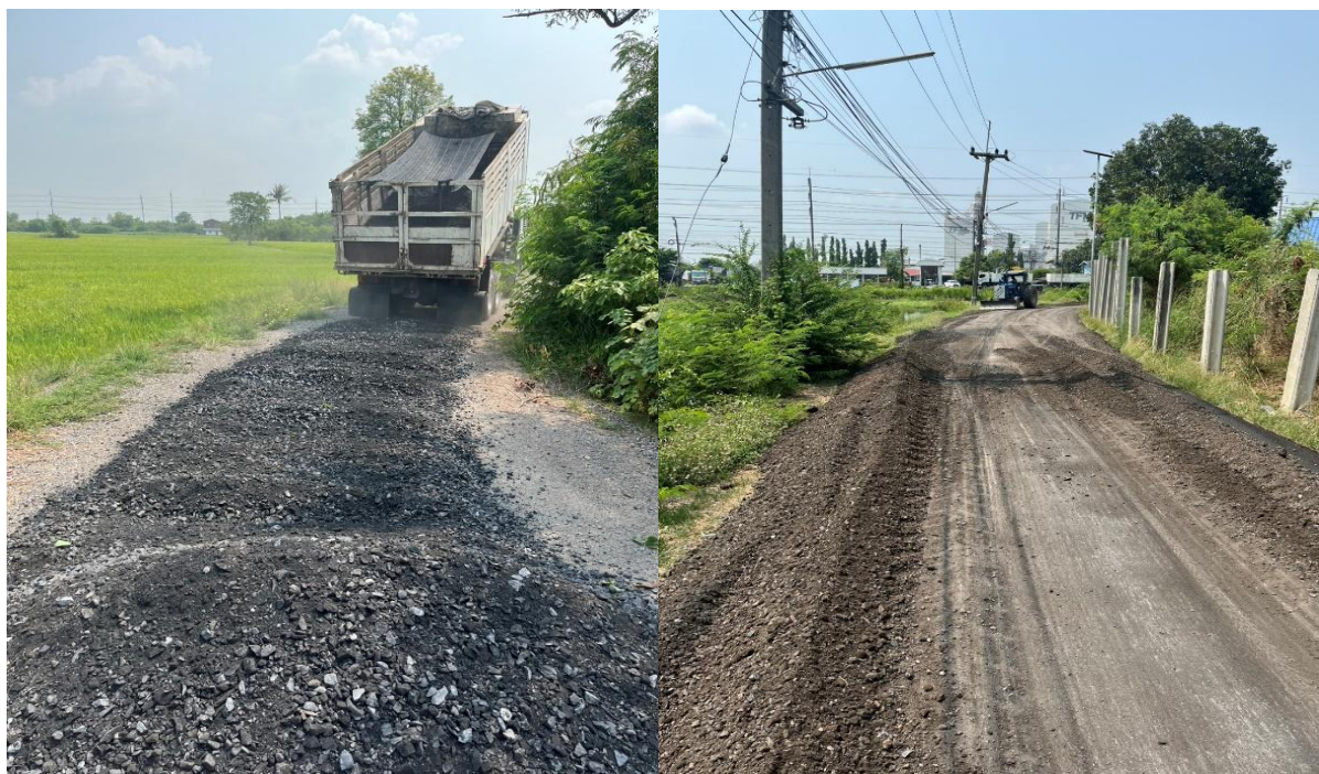
หินคลุกซ่อมแซมถนน ภายในเขตตำบลต้นตาล-ตำบลพระยาท อำเภอสายใต้ จังหวัดสระบุรี
