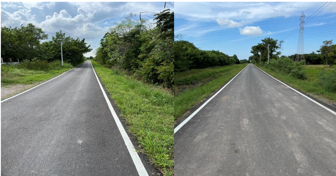
ถนนลาดยางแอสฟัลท์ติกคอนกรีต หมู่ที่ 7 ตำบลต้นตาล อำเภอเสนาห์ จังหวัดสระบุรี (โรงพยาบาลสัตว์ - คลองห้วยแร้ง)
