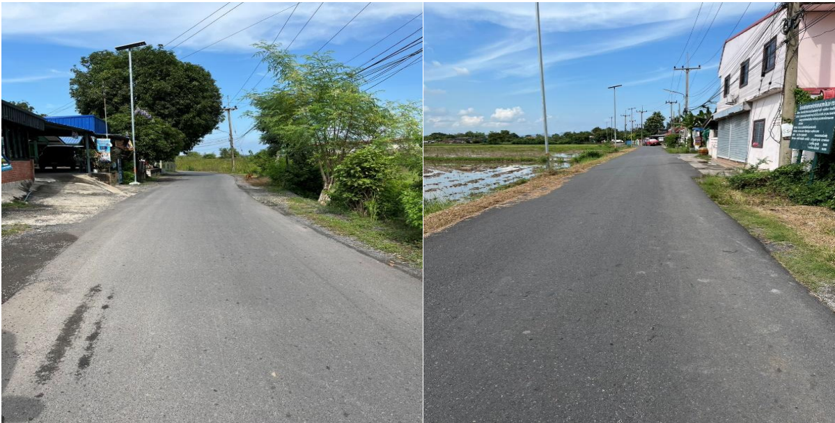
ถนนลาดยางแอสฟัลท์ติกคอนกรีต หมู่ที่ 8 ตำบลต้นตาล อำเภอเสนาห์ จังหวัดสระบุรี (ทางเข้าหมู่บ้านเตียรชัย)
