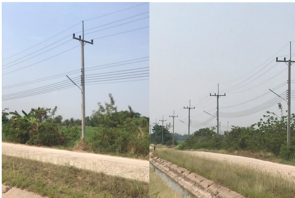
โครงการพาดสายไฟและติดตั้งโคมไฟฟ้าสาธารณะหมู่ที่ 6 ตำบลพระยาทต อำเภอสายไ้ จังหวัดสระบุรี
