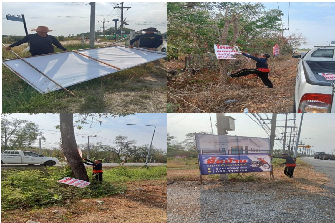
รื้อถอนเก็บป้ายที่ไม่ได้รับอนุญาต
