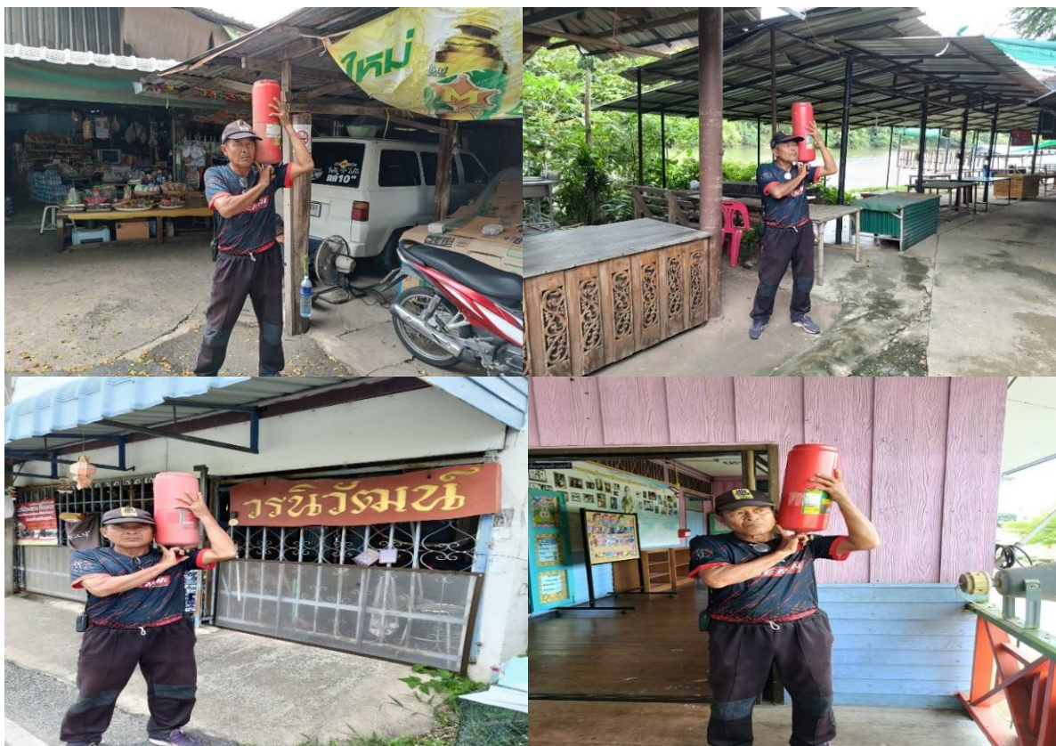
สำรวจ/จัดซื้อพร้อมติดตั้งถังดับเพลิงในพื้นที่ตำบลต้นตาล ตำบลพระยาท
